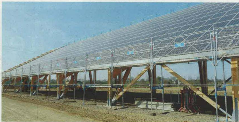
La première "coque" est sortie de terre au Chêne au Loup.
